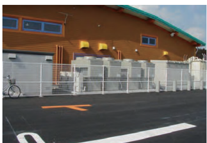
コの字タイプの防音壁(設置前と後)
