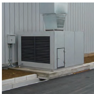
ファン防音ケーシング (側面はフィルタ付き給気口)
